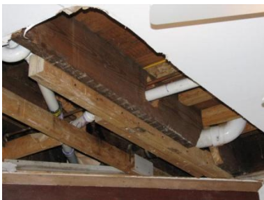
Slika 6.2. Oštećeni gredek
